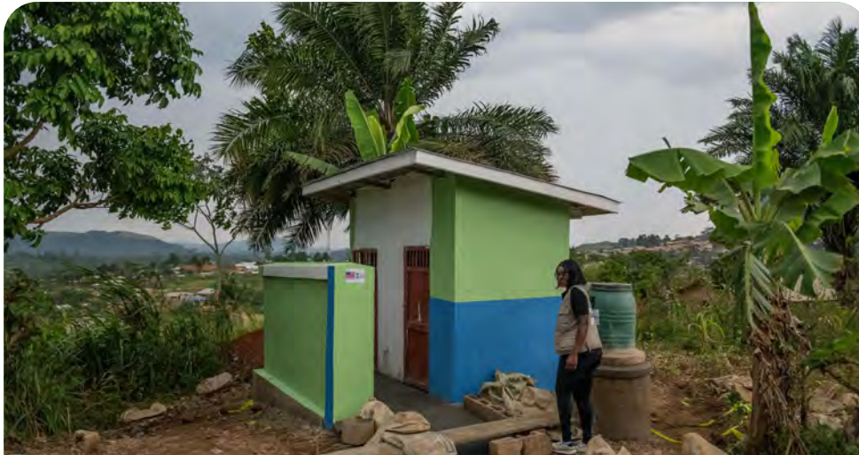
📷 Blandine Mambiko, inspecciona las letrinas y una estación elevada para lavarse las manos construida por Acción contra el Hambre en CECA 20 para mejorar las normas de higiene y ayudar a prevenir la transmisión del ébola, en Mongbwalu (RDC), el 24 de junio de 2026. ©Patient Kabukulu para Acción contra el Hambre.
